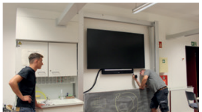
Displays - hier im Fachraum der JAS - wurden hinter die Tafeln montiert
